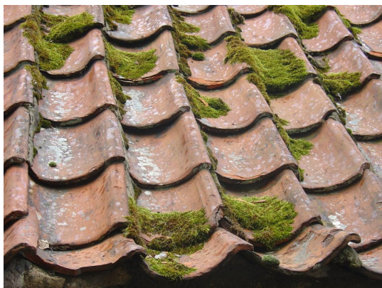
Photo 4, Mousses et tuiles poreuses, versant nord
